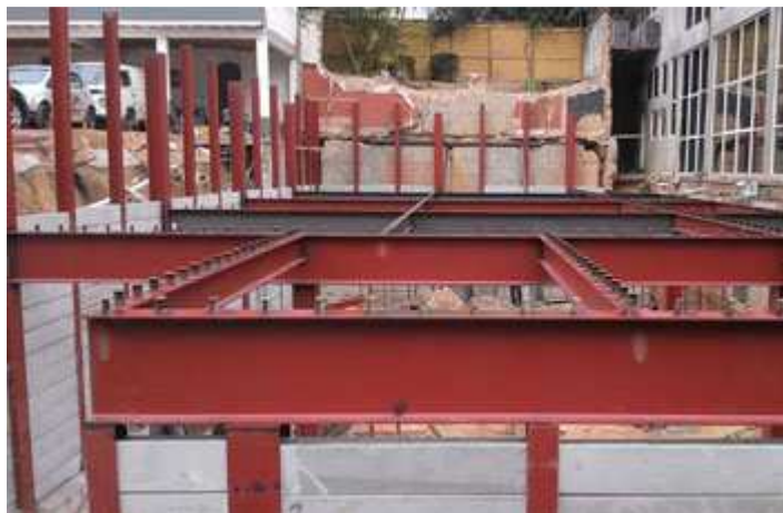
Edifício Metálico – Estacionamento
