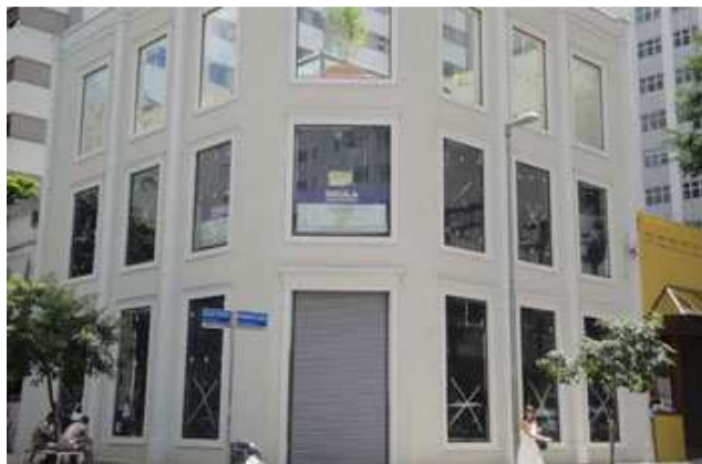
Edificação Comercial Oscar Freire
