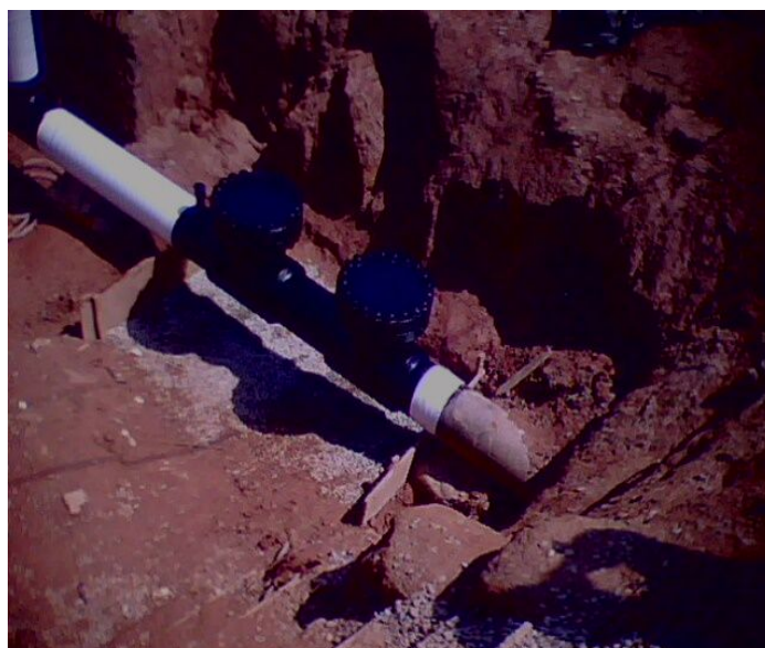
Figura 24 – finalizando o processo de pintura antes do enterro da tubulação Foto por Aelson Lopes
