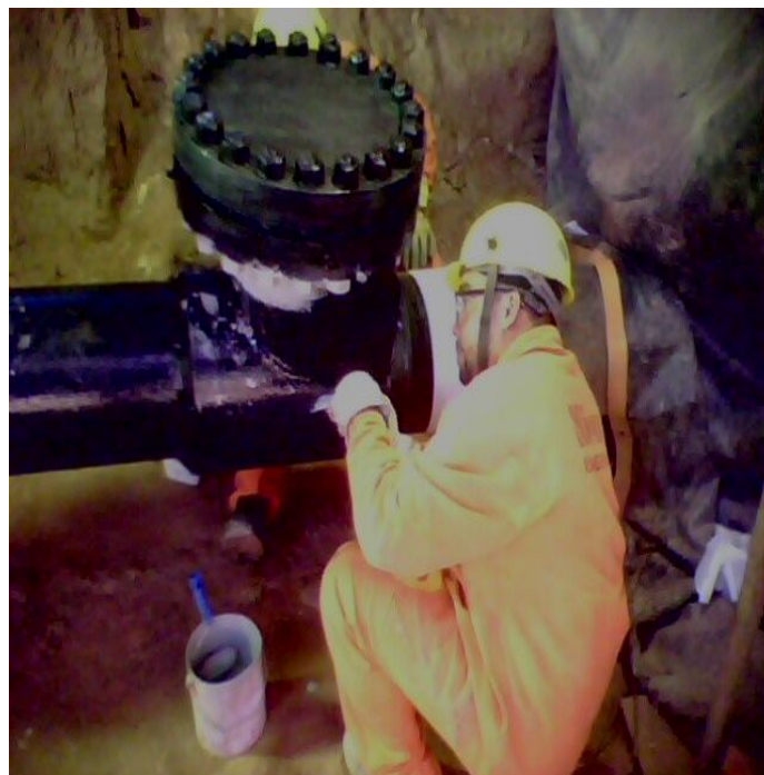
Figura 22 – Pintura da conexões Foto por Aelson Lopes
