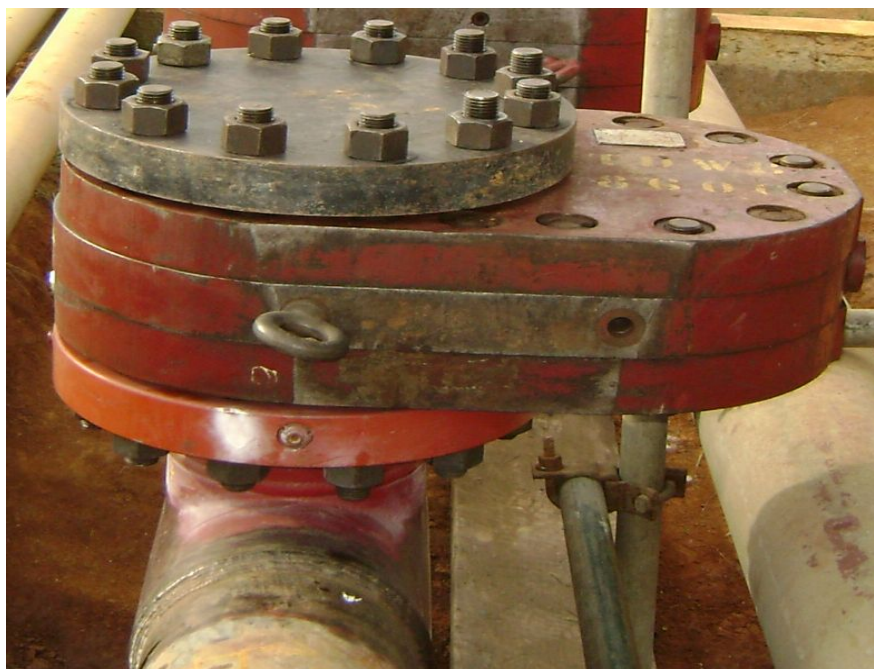
figura 06 – Válvula de bloqueio manual tipo Sanduíche Foto por Aelson Lopes
