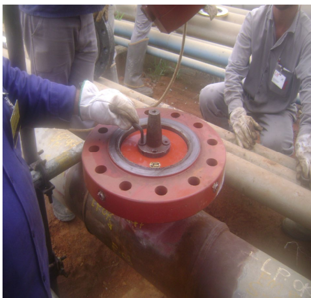
Figura 19 – Dispositiva de vedação fixado no flange das conexões Fitting Foto por Aelson Lopes
