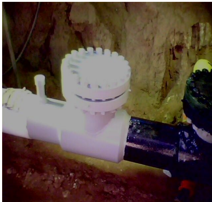
Figura 23 – Pintura final da tubulação e das conexões flange Foto por Aelson Lopes
