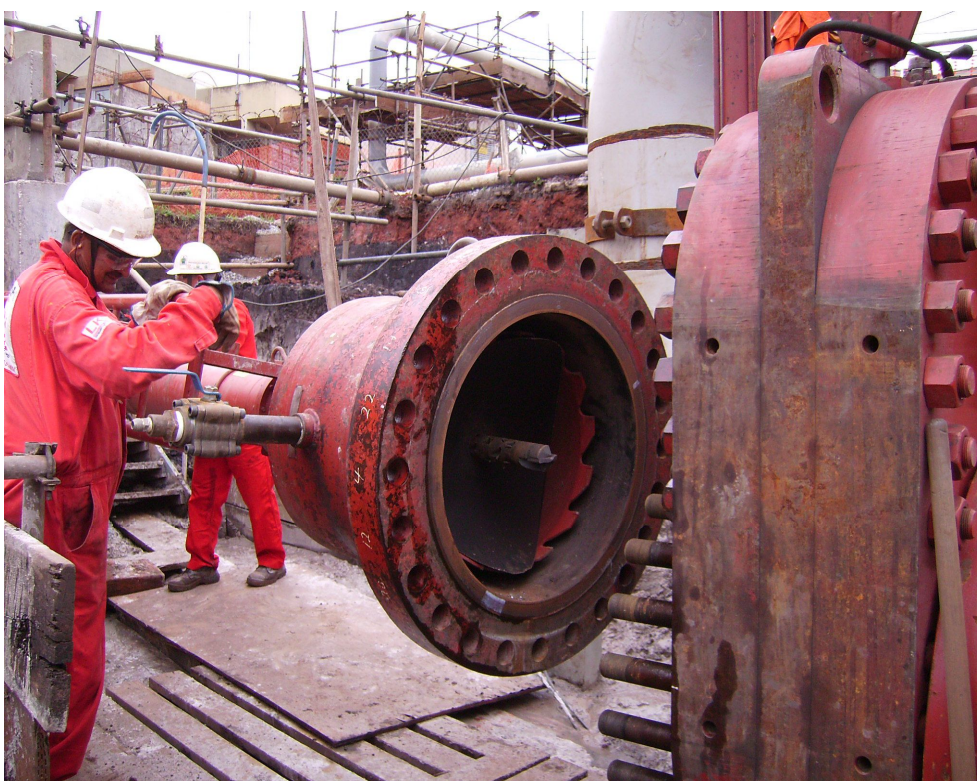
Figura 09 - Removendo a Válvula tipo Serra copo após o furo da tubulação Foto por Aelson Lopes
