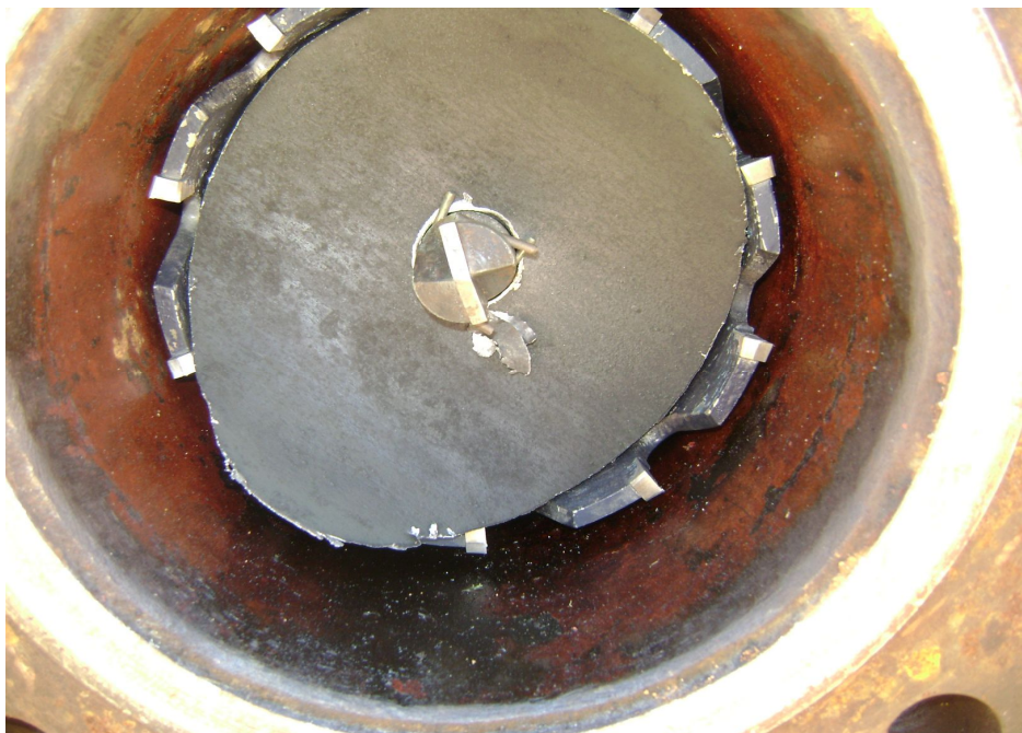
Figura 10 - Retirando a válvula serra copo após furo Foto por Aelson Lopes
