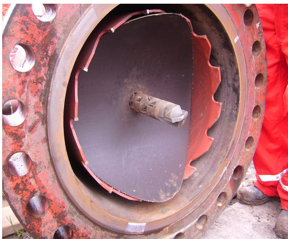
Figura 11 – Válvula serra copo com tarugo da tubulação Foto por Aelson Lopes
