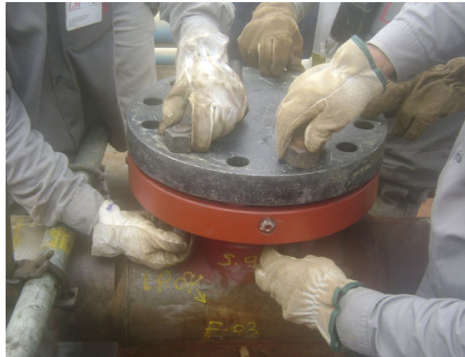
Figura 21 – Instalação de Flange Cego de vedação final na conexão Fitting Foto por Aelson Lopes
