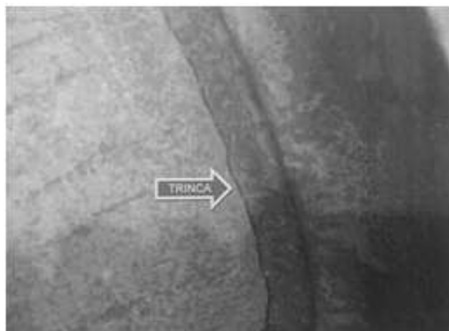
Exemplo de trinca de fadiga na região de solda de fixação entre eixo e anel.
