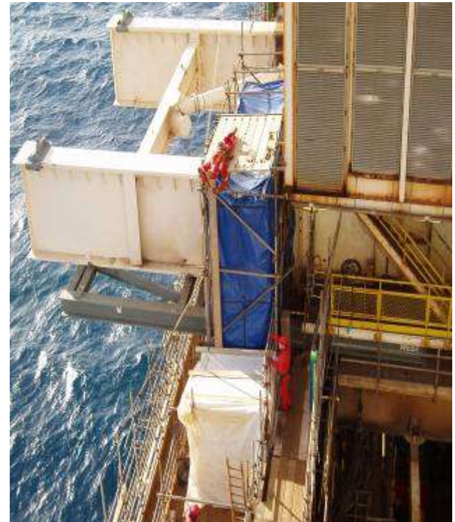
Enclausuramento para trabalho em grande estrutura de aço
