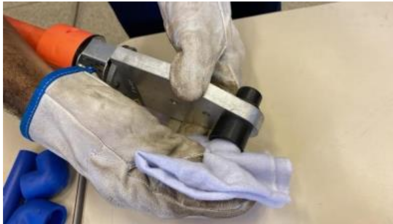
Figura 13 - Limpeza do soquete 25mm
