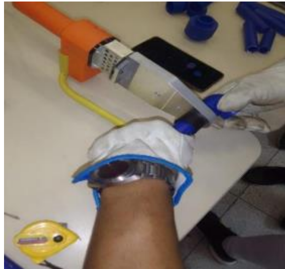
Figura 16 - Soldagem modo soquete
