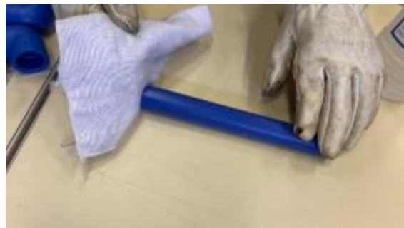
Figura 14 - Limpeza do PP 25 mm (conforme DVS 2207-1)
